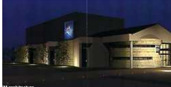
Entamés en juin 2006, les travaux de rénovation de La Pléiade ne devraient pas être terminés avant mi-2009.
